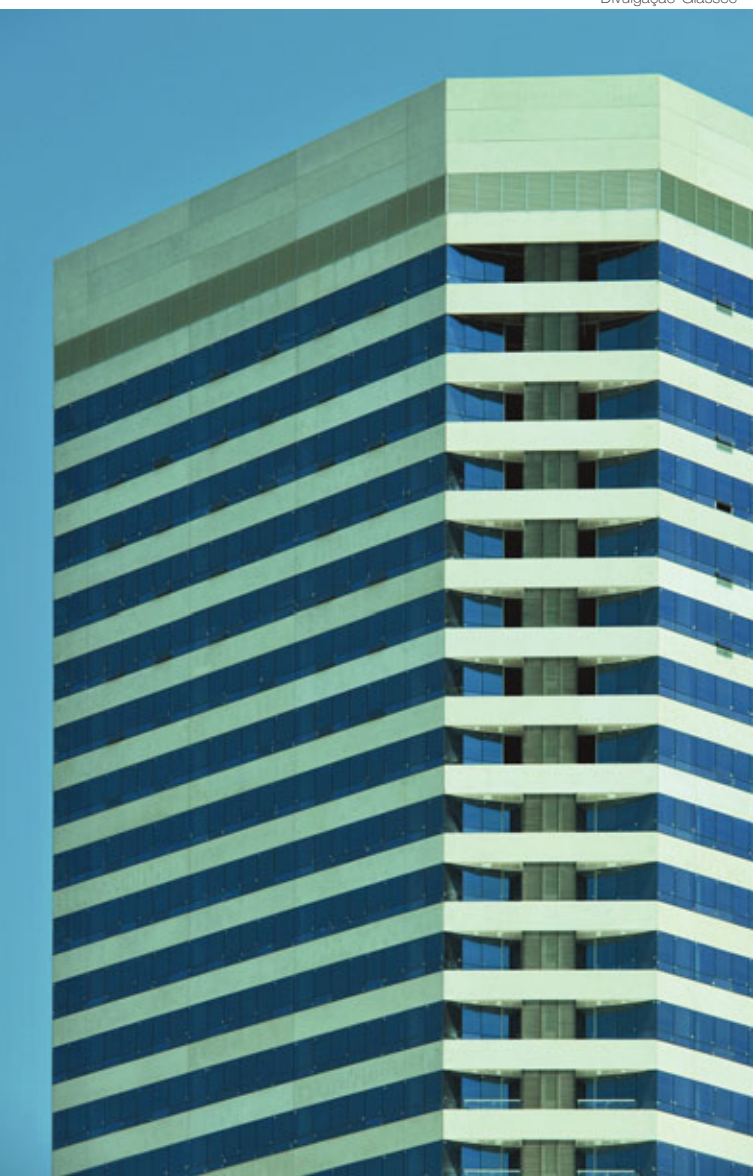
No edifício I-Tower, em Barueri, São Paulo, a Glassec forneceu vidros de controle solar laminados low-e azuis
