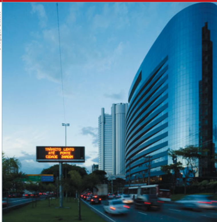
Edifício Landmark, em São Paulo: vidros de controle solar laminados low-e azuis fornecidos pela Glassec
