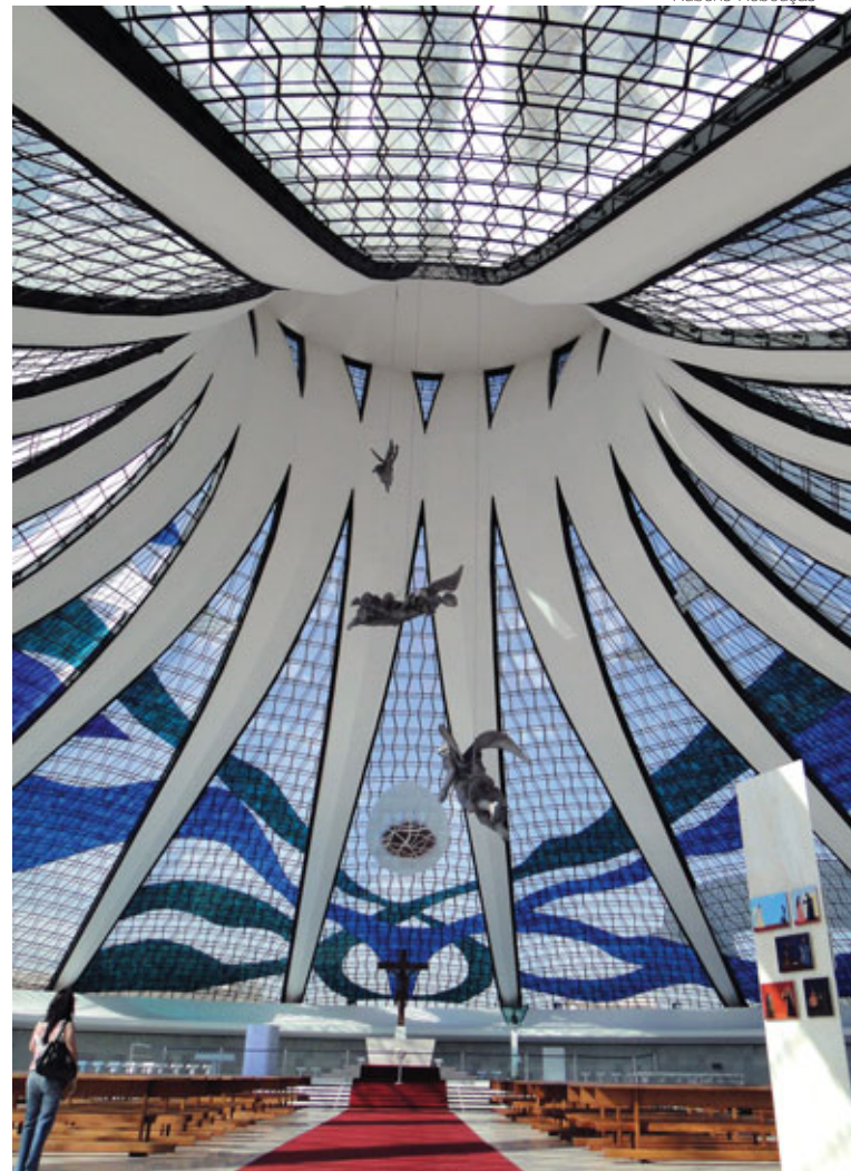
Catedral de Brasília: reformada, recebeu vidros de controle solar e low-e da Cebrace
