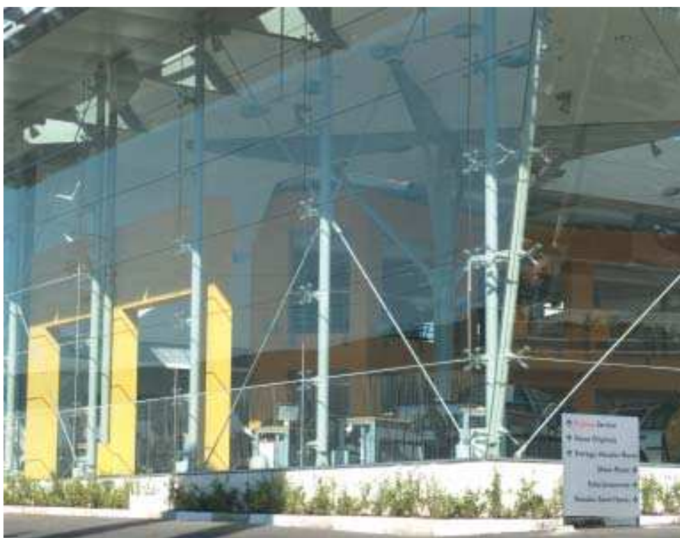
TG System, da Pilkington, obedece ao conceito de fachada estrutural e privilegia o vidro
