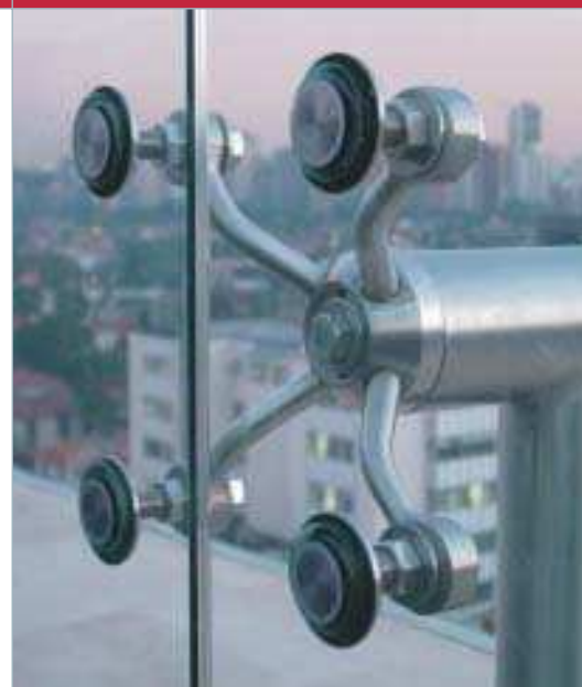
Só se for temperado: sistema da Saint-Gobain recebe vidros fabricados por processo de têmpera especial
