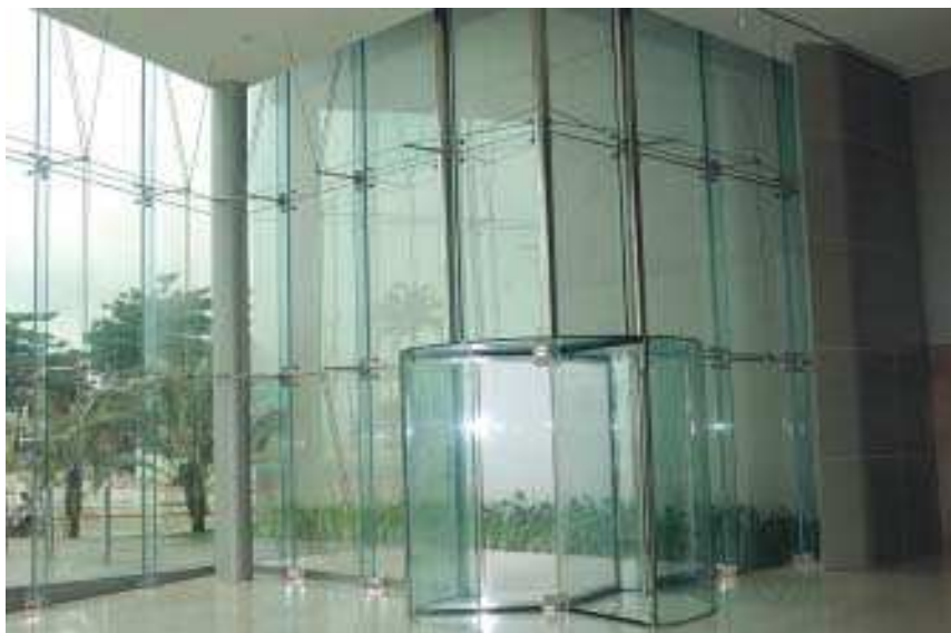
Os quadros pré-fabricados, da Avec Design recebem vidros de 8 a 14 mm e são fixados à estrutura do prédio com ancoragens de alumínio
