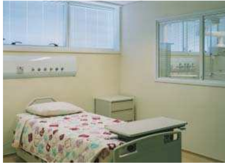
Trânsito intenso: janelas do Hospital São Camilo receberam vidros duplos para isolar o ruído da Avenida Pompéia, em São Paulo
